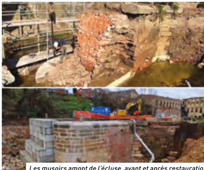
Les musoirs amont de l'écluse, avant et après restauration
